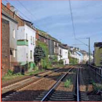
Güterverkehr mitten durch den Ort lässt Häuser verfallen (Lorchhausen)
