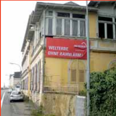
Ehemaliges Hotel in Koblenz-Stolzenfels
