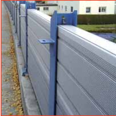
Lärmschutzsystem aus Aluminium mit innenliegenden Dämmmatten
