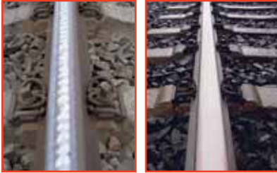
Links: Schiene mit ausgeprägten Riffeln Rechts: nach dem oszillierenden Schleifen
