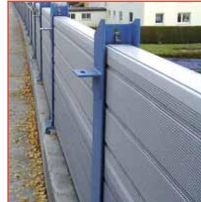
*Lärmschutzsystem aus Aluminium mit innenliegenden Dämmmatten*
