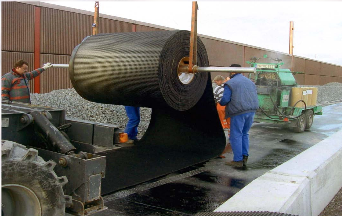
Unterschottermatten werden längs zur Gleisachse lagestabil auf der Troginnenseite verlegt.
